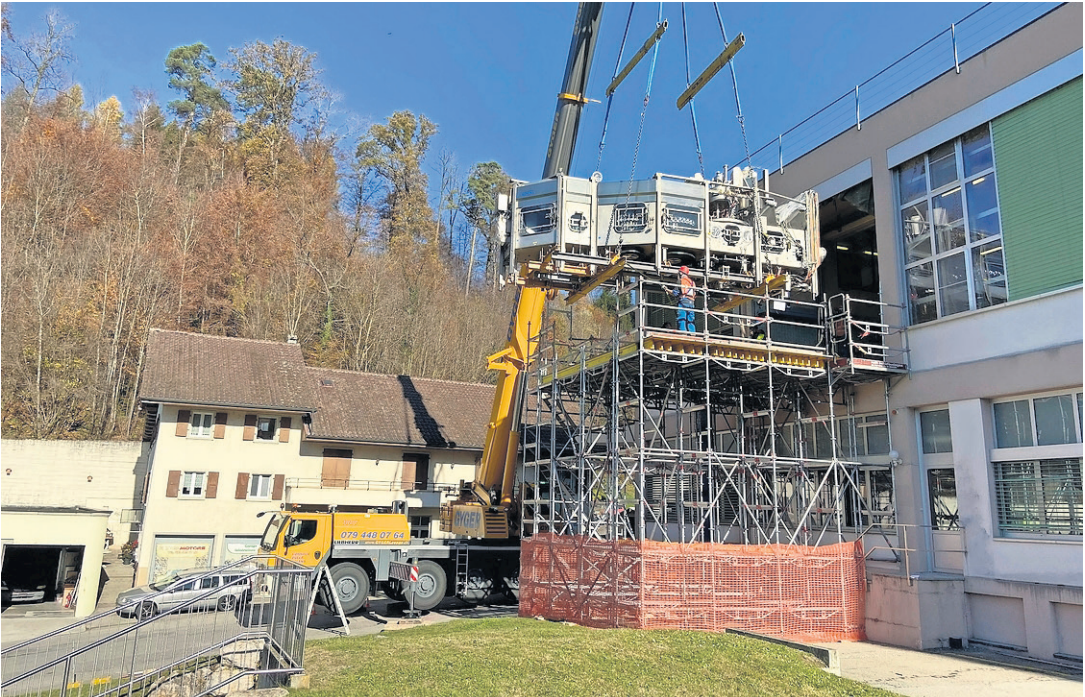
Pour permettre de déplacer l'imposante soutreuse (3,5 mètres de hauteur sur 8 mètres de longueur, 12 tonnes) qui remplit les bouteilles de jus de fruits a nécessité l'ouverture d'un mur de l'usine du village d'Henniez. PHOTO NESTLÉ WATERS SUISSE
